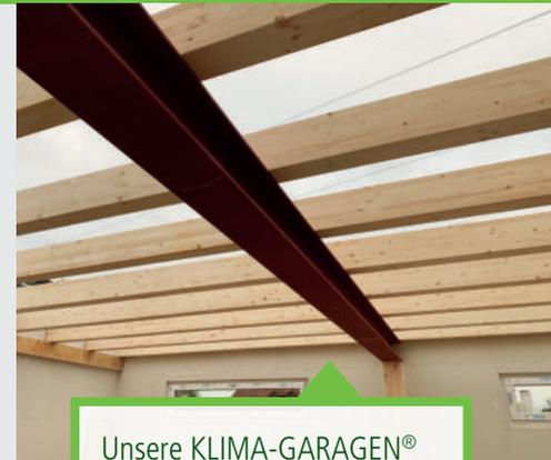
Unsere KLIMA-GARAGEN® können durch Erhöhung der Anzahl der Dachsparren und dessen Querschnitte (Dachpfetten) eine maximale Dachbelastung von bis zu 500 kg pro m<sup>2</sup> erreichen – je nach statischer Erfordernis.
